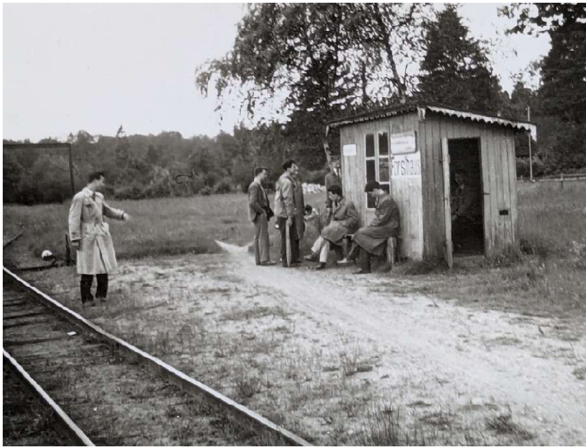
Zwischen Luhnstedt und Nindorf befand sich die Bedarfshaltestelle Forsthaus. Hier gab es eine Verladestation für Langholz.
