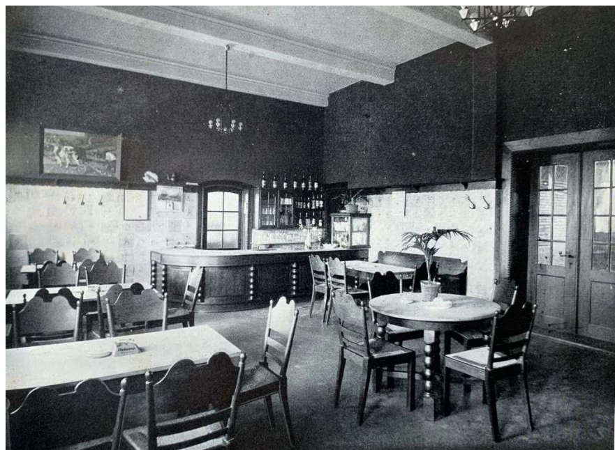
Der Warteraum im Empfangsgebäude in Rendsburg.
