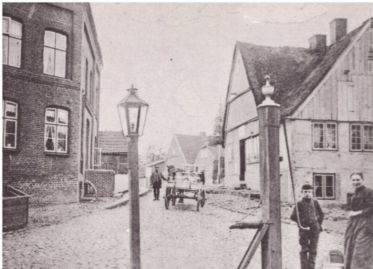
Pumpe Ecke Bergstraße Kieler Straße um 1900
